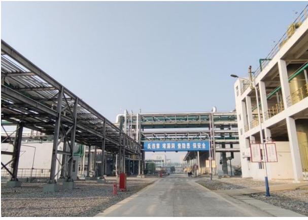
东大化学公司内管廊现状照片
