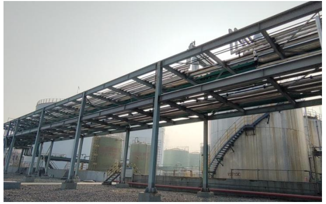
东大化学公司内管廊现状照片
