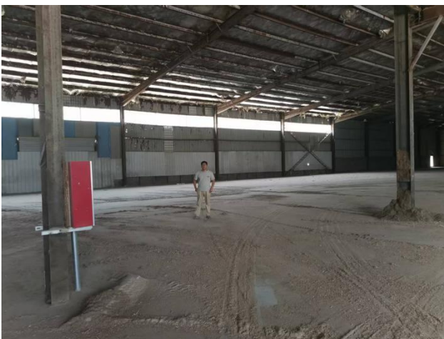
车间内部现状图
