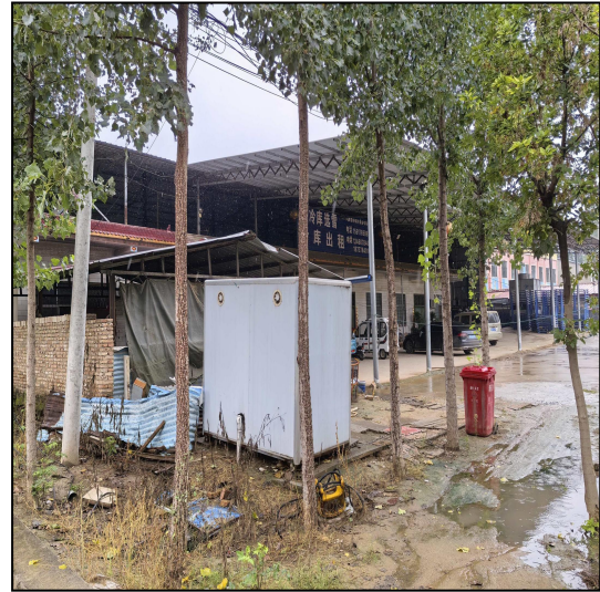
项目东侧冷库
