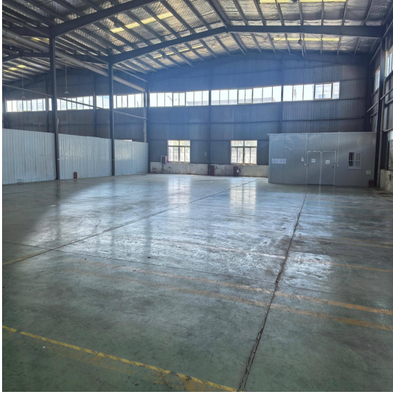
项目厂区现状
