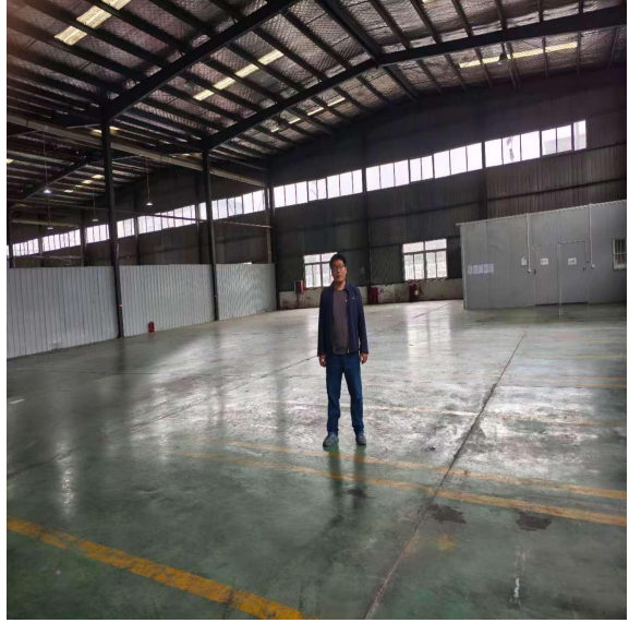
工程师踏勘现场照片
