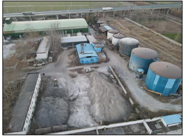
项目拟拆除现有工程
