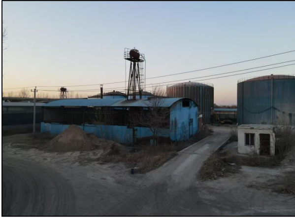
项目拟拆除现有工程
