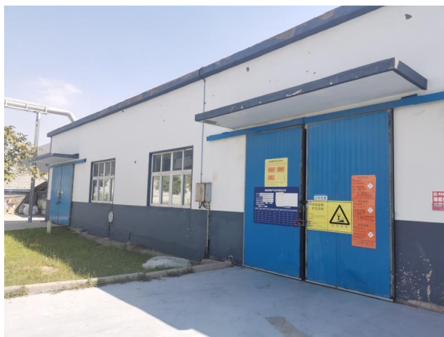
危废暂存间现状
