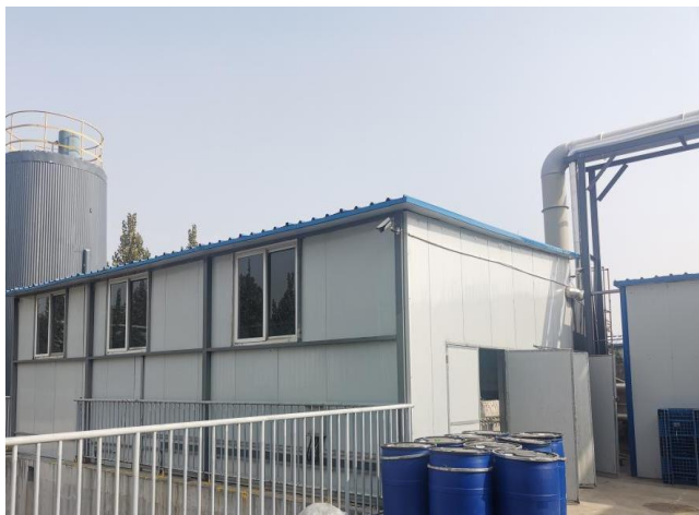
废水处理设施现状
